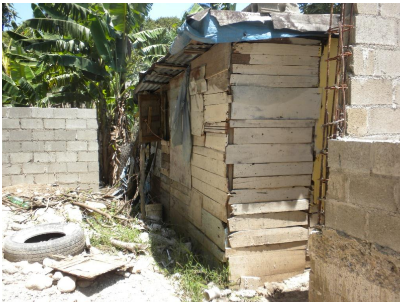
Image 4 : Cuisine improvisée et logement de fortune sur un chantier privé à Santiago de los Caballeros.
