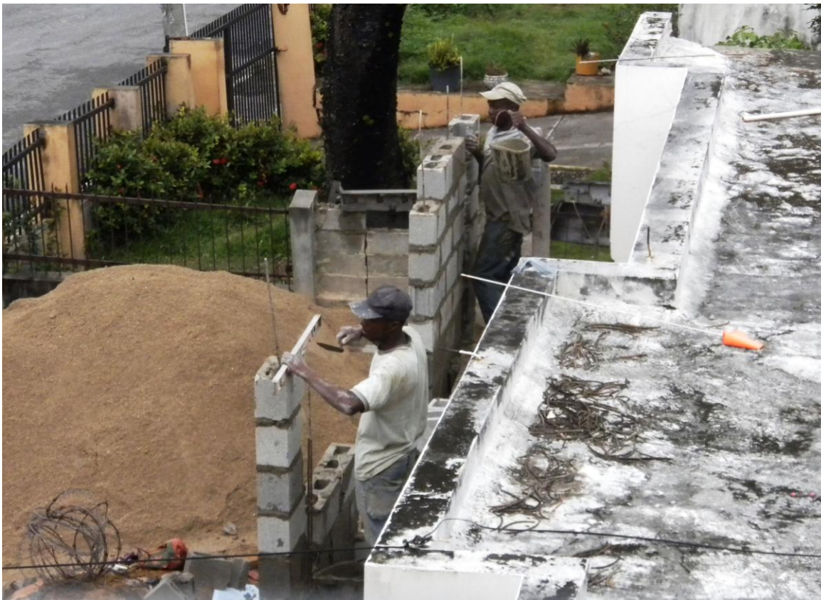
Image 1 : Des maçons haïtiens au travail sur un chantier résidentiel à Saint Domingue.
